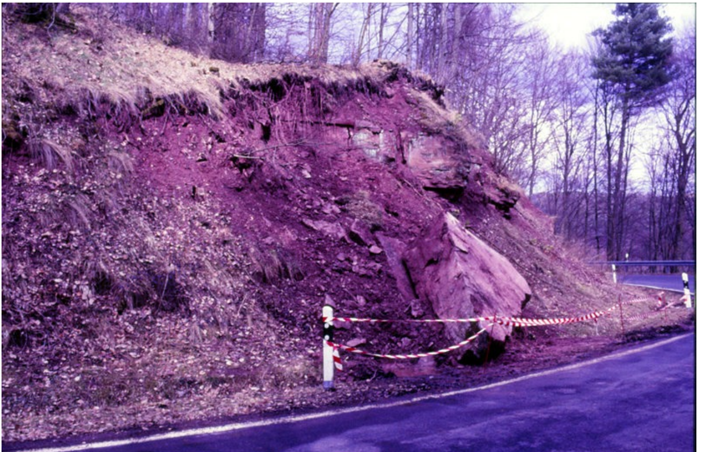
Felsen nach Abbruch, Abrutschen und Zerteilung 1987
